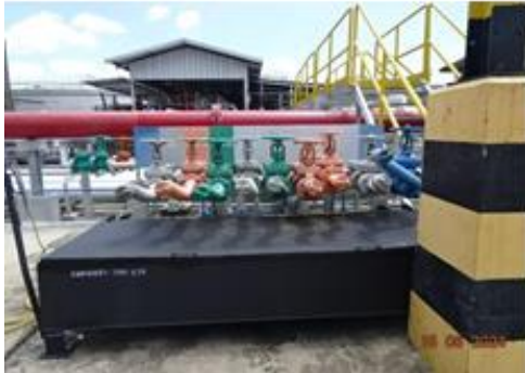
ภาพที่ 2-2 (ต่อ) ถาดรองรับน้ำมันที่อาจรั่วไหลจากการถอดและเชื่อมต่อในการขนถ่ายน้ำมันที่ท่าเรือ
