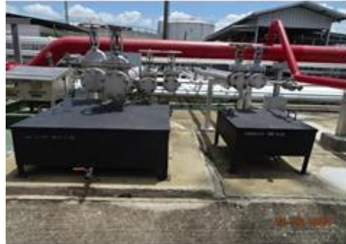
ภาพที่ 2-2 (ต่อ) ถาดรองรับน้ำมันที่อาจรั่วไหลจากการถอดและเชื่อมต่อในการขนถ่ายน้ำมันที่ท่าเรือ
